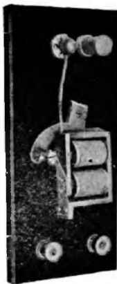
Fig. 2. Coherer enafkloper.
